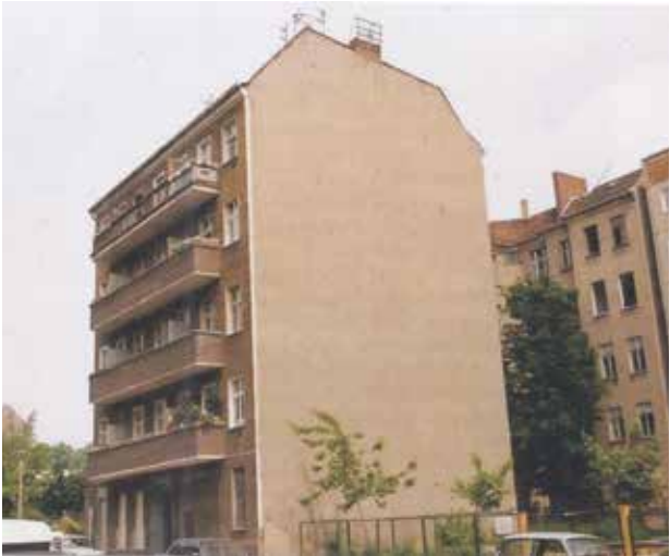
A ház „szocreál” stílusban helyreállított homlokzata, 1991
